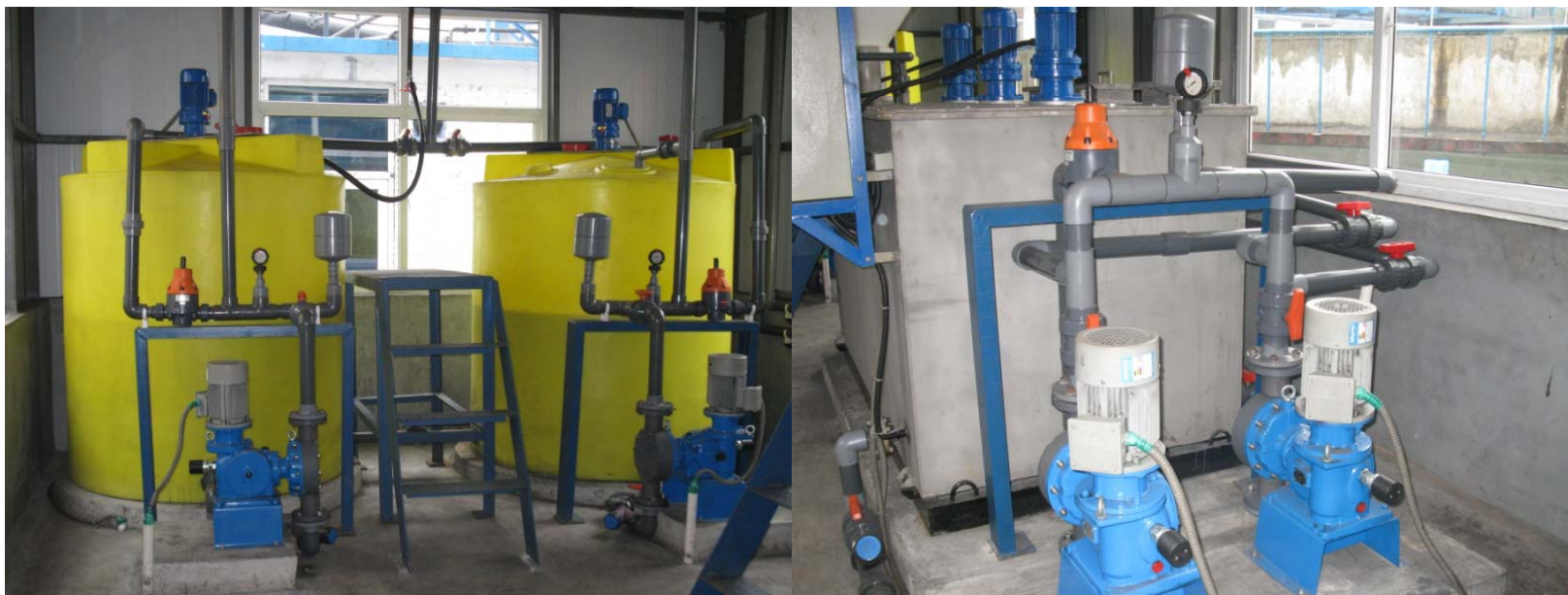
山西长治某洗煤厂加药系统配套计量泵（MS4系列）
